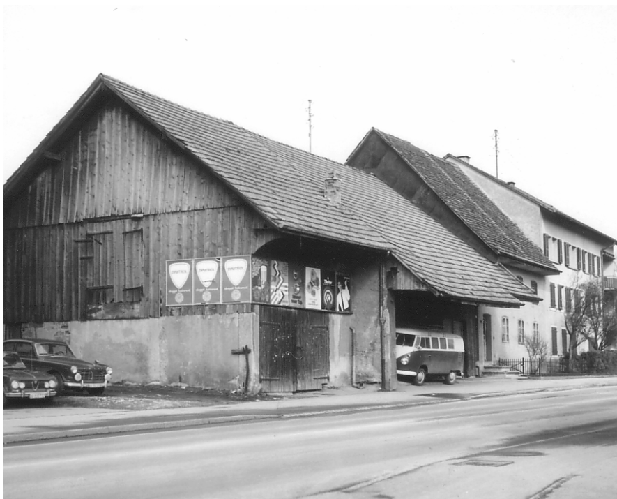
Diese Häuser und die Scheune wurden abgerissen.
