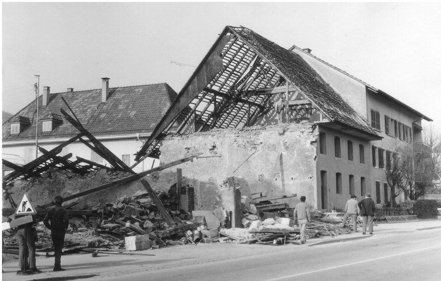
Abbruch von Westen her betrachtet
