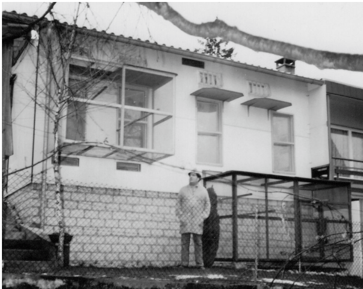
Dieser Anbau am Wohnhaus an der Sonnhalde war der Taubenschlag. Bis zu 50 von ihm gezüchtete Tauben hatten darin Platz. Bruno Mäder (er war Schreinermeister) hat das Gebäude und den Innenausbau selbst entworfen und gebaut.
