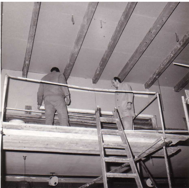
Arbeiten an der Saal-Decke
