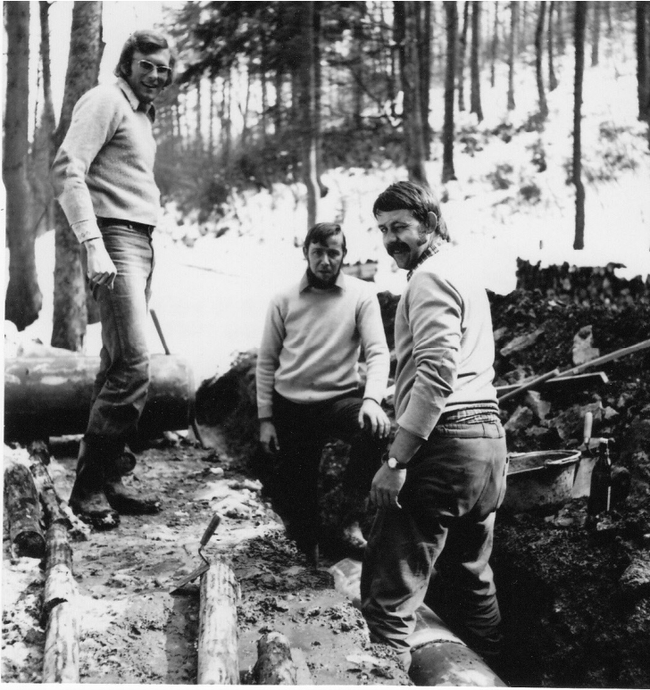
Kanalisations-Rohre wurden verlegt. Die Zünftler hatten viel Spass bei diesen Arbeiten: v.l. Roman Rüede, Ruedi und Niklaus Leuenberger.
